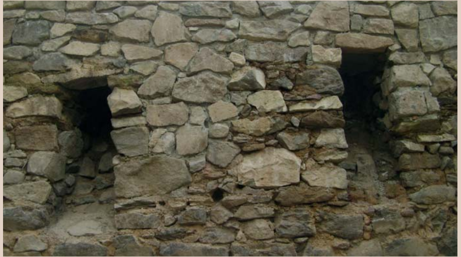
Freigelegte Rauchabzüge im Mauerwerk der mittelalterlichen Münzstätte in Zwickau.
