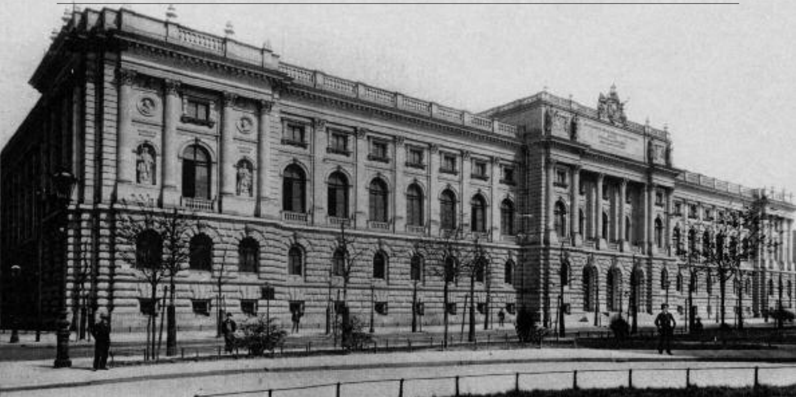
Abb. 1: Hauptgebäude der Universitätsbibliothek Leipzig (Biblioteca Albertina) von 1891 (Das Gebäude wurde im 2. Weltkrieg zerstört, Wiederaufbau und Erweiterung 1994–2002)
